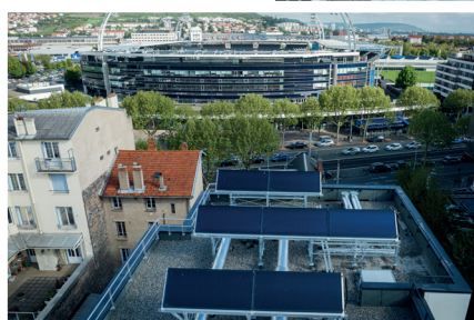
Capteurs solaires en toiture
