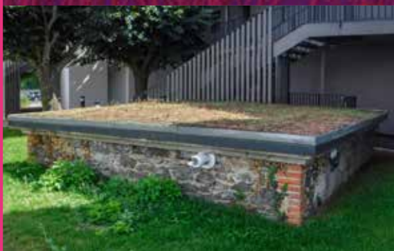
Édifice intégrant la PAC
